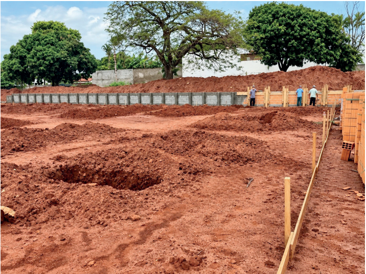
Construção da Unidade Mista de Saúde (UMS)
