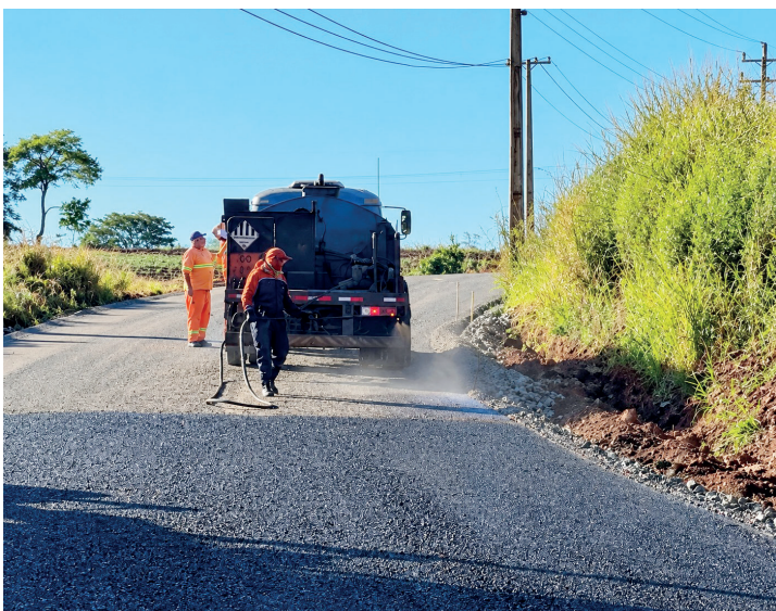
Pavimentação asfáltica nas estradas rurais
