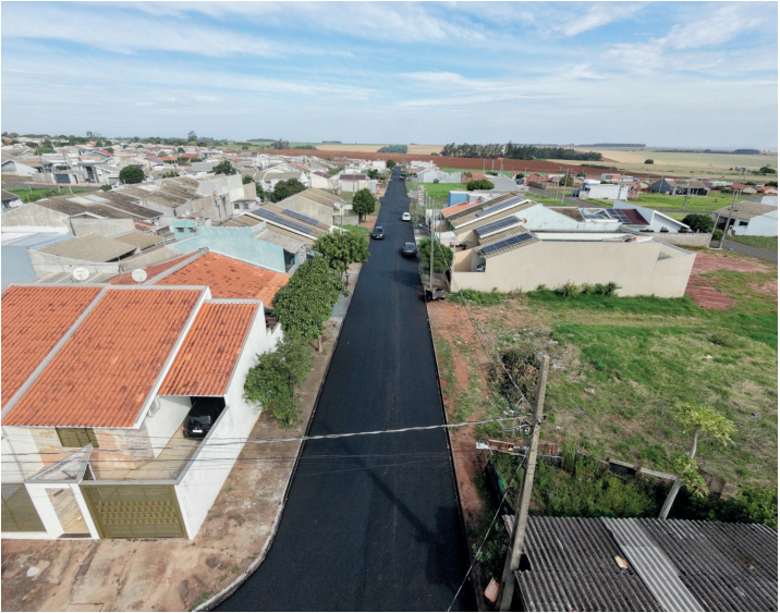
1ª etapa do recape asfáltico
