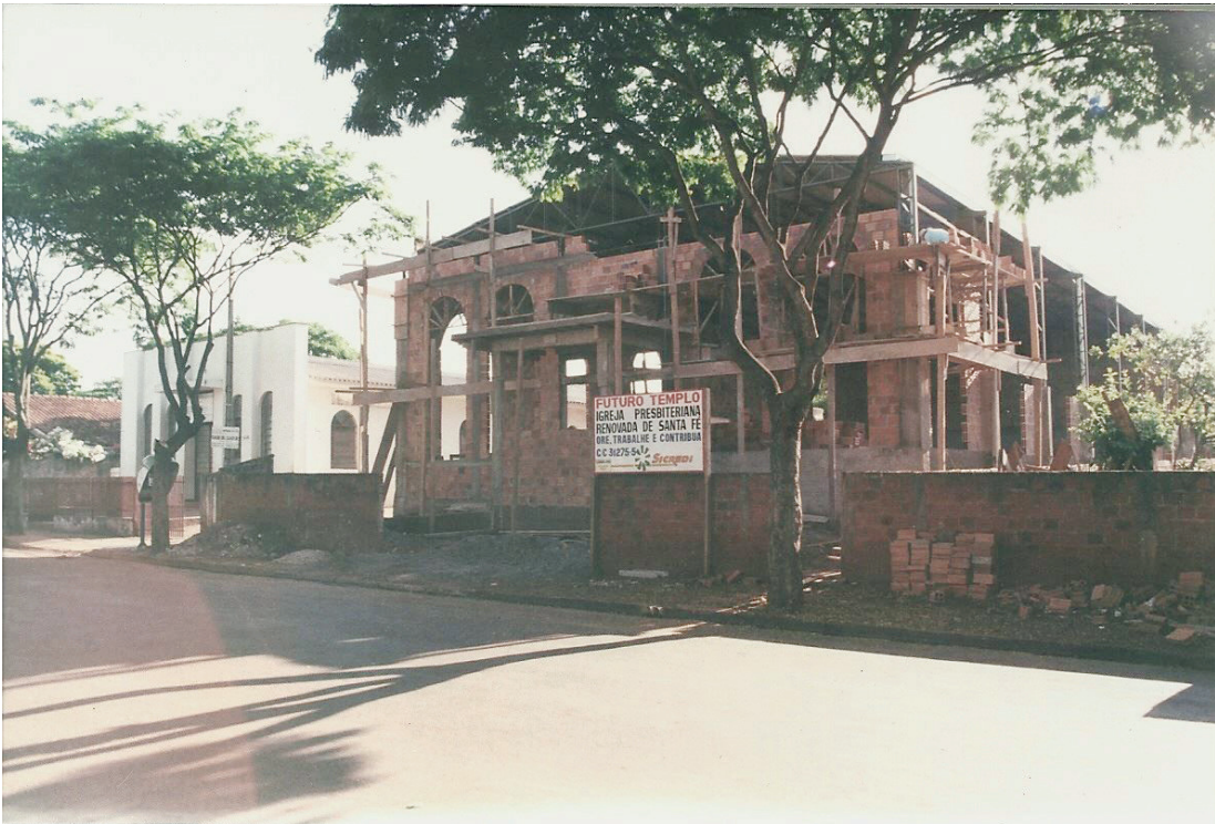
Construção do Templo da Igreja Presbiteriana Renovada (a terceira). Foto: Pastor José Altair Vedovelli.
