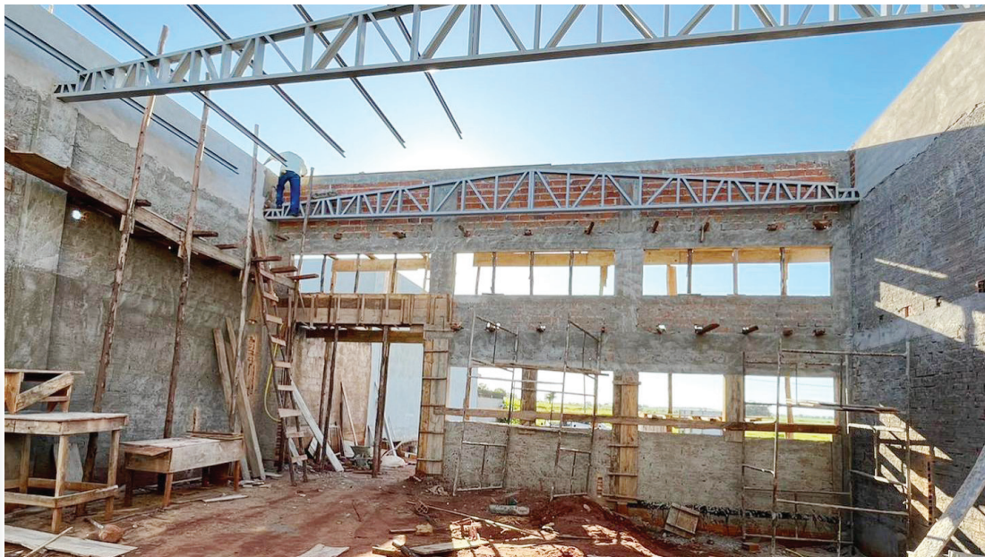
A construção do Barracão Industrial, na Rua José Cesnik, está em andamento. A obra, de aproximadamente 153 m², está sendo feita com recursos próprios do município e soma o valor de R$ 500 mil. A administração municipal agradece a equipe que tem se dedicado cada dia para que todos os projetos saiam do papel.
