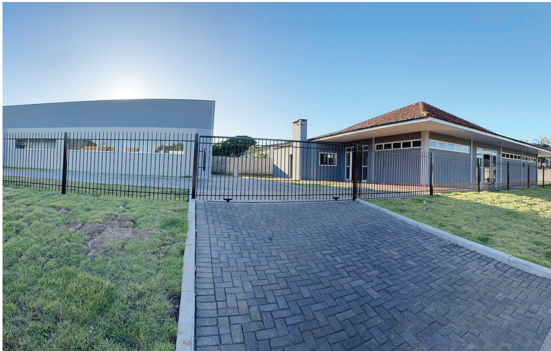
A obra de melhorias na piscina do Centro do Idoso encontra-se em fase final de acabamento. Além do aquecimento da piscina, os trabalhos contemplam a cobertura, aumento do espaço da calçada - com a colocação de paver, instalação de portão e grade. A saúde dos idosos no município de Flórida é marca da atual administração.
