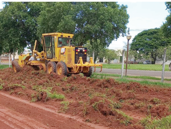
O Meu Campinho está sendo construído ao lado do Centro Poliesportivo Orlando Tomazini
