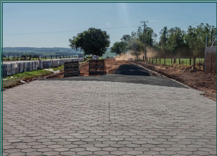
Os trabalhos de pavimentação - blocos sextavados, no Distrito de Valência, estão a todo vapor. O trecho compreende uma extensão de 1.700 metros e fica localizado na estrada da Balsa. O valor do convênio é de R$ 1 milhão.
